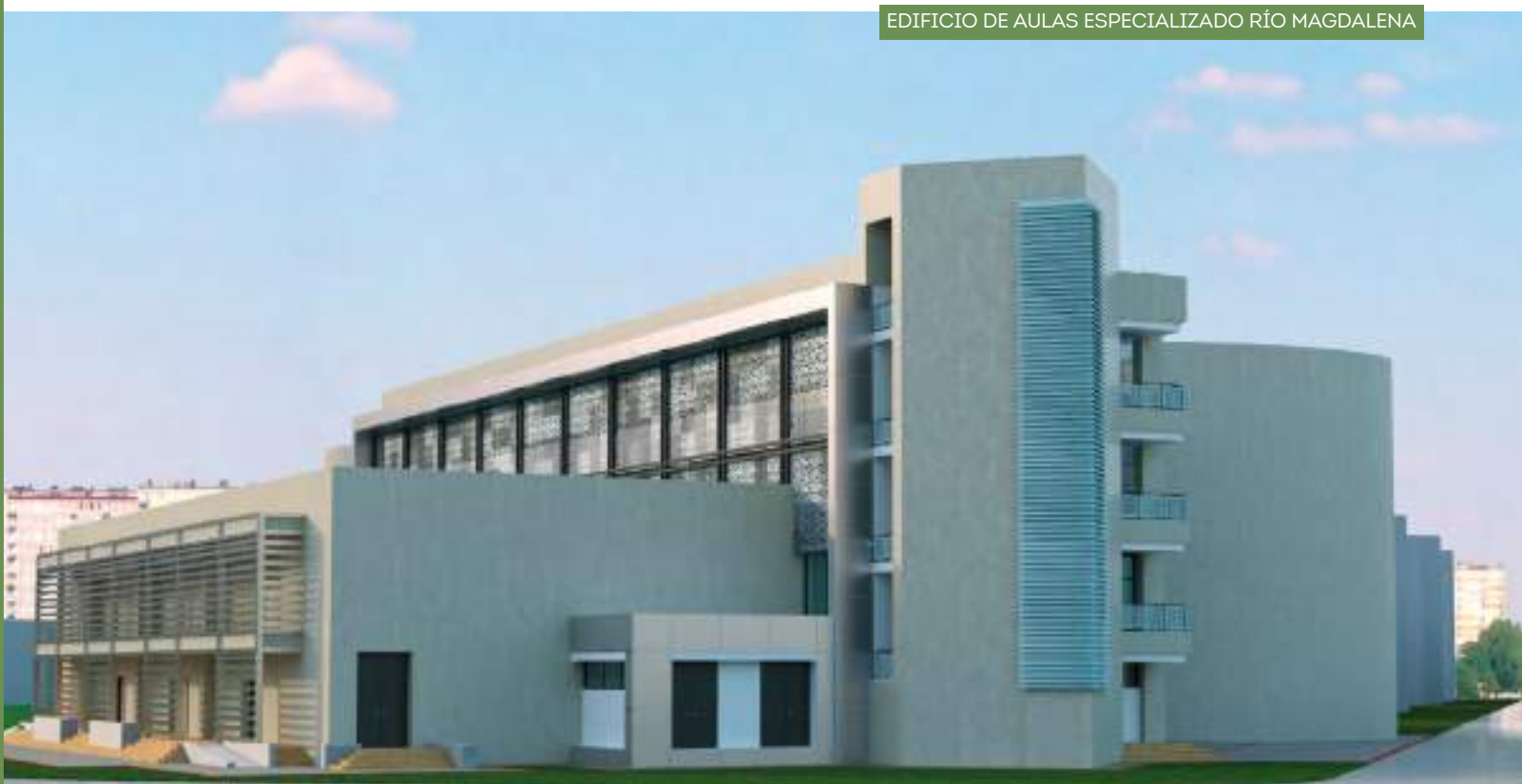
EDIFICIO DE AULAS ESPECIALIZADO RÍO MAGDALENA
